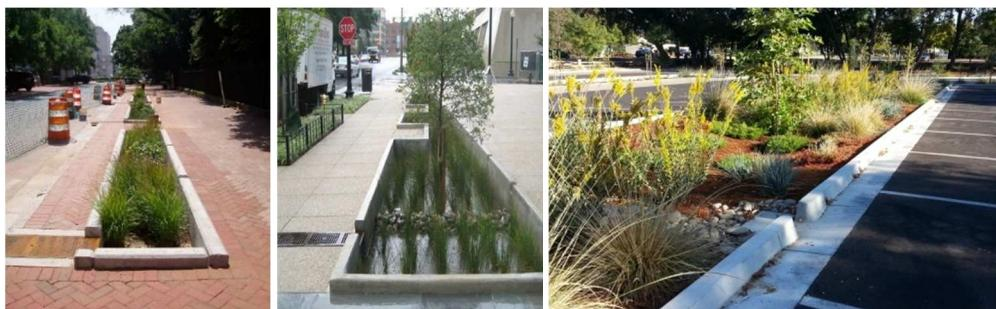
**Figure 5.** Infiltration planter: a) (Photo: WEB-4, 2021); b) Washington, USA (Photo: WEB-2, 2021)
