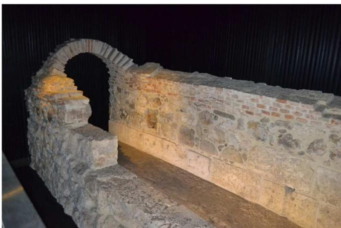
**Figura 1:** Galería de abastecimiento de agua conservada en el Museo de los Caños del Peral situado en la estación de Metro de Opera. (Foto: P.C. Izquierdo, 2021)
