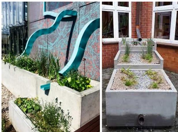
Rys. 4. Ogrody deszczowe przepływowe: a) przy budynku InfoBox w Gdyni, Polska;
